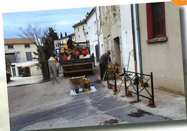
Barrières rue du moulin
