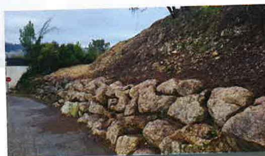
Débroussaillage rue du Cercle et chemin du queyron
