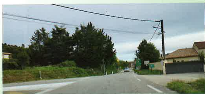
Lancement de la première tranche de travaux de la route départementale
