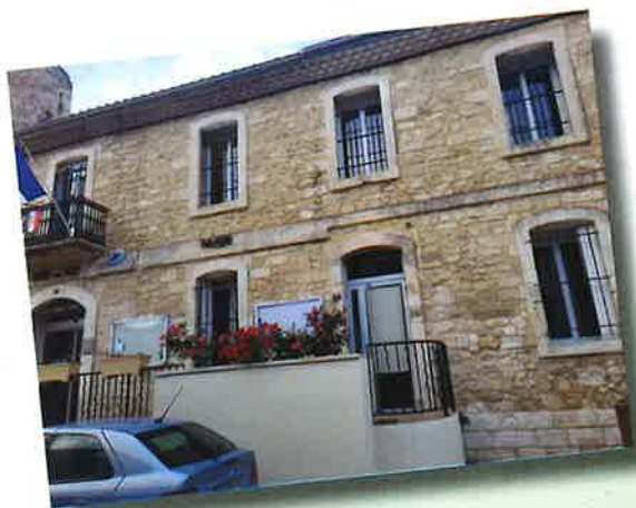
Réfection menuiseries mairie
